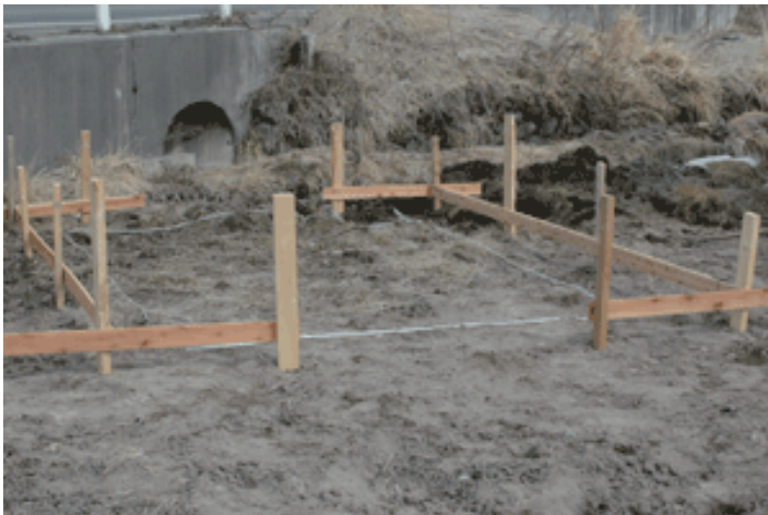
貫板が打ち終わった状態
