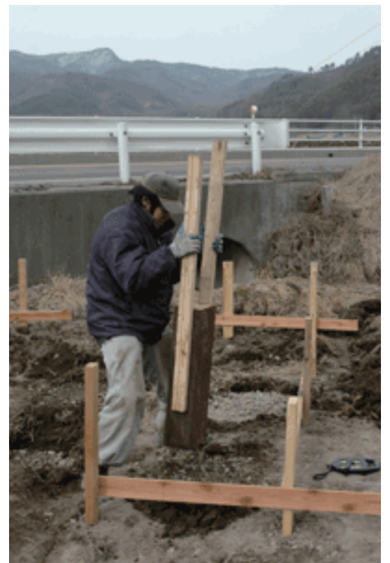
碎石の突き固め
