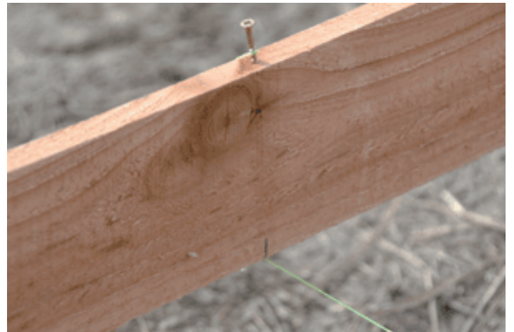
貫板にビスを打ち糸を張る (写真は貫板の下から水糸を通した方法)
