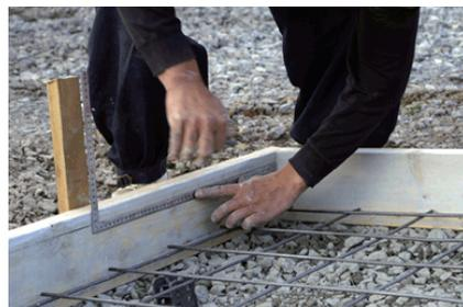
差し金などを使い、スロープ部分の斜めの仕上がりラインと水平部分のラインの交点を明確にして下さい。
